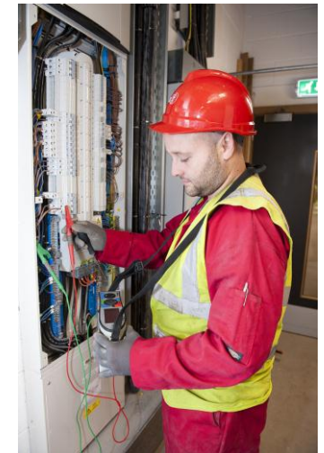
Forth Electrical Services Inbetriebnahme eines Terasaki Pro-DB Verteiler in der Arena
